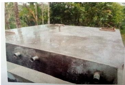
Gambar 2. Tampak Samping Bangunan PAMSIMAS
