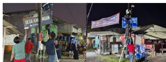
Foto 5. Pencopotan signage lama dan Pemasangan signage baru
